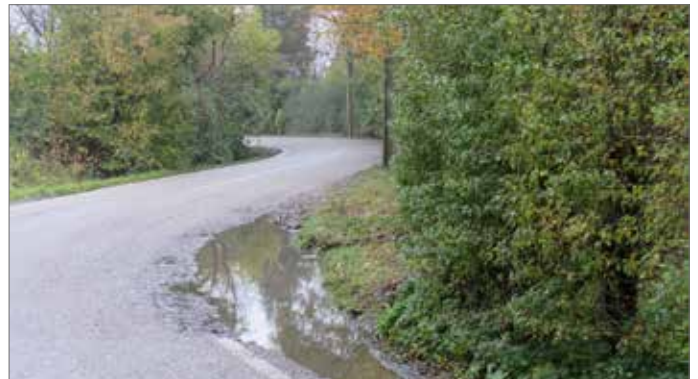
▲ De gevaarlijke put in de Wijnegembaan wordt op vraag van de N-VA eindelijk hersteld.
